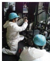
被災会社の設備の復旧作業
