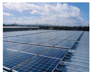
工場の屋上に設置された太陽光発電パネル
