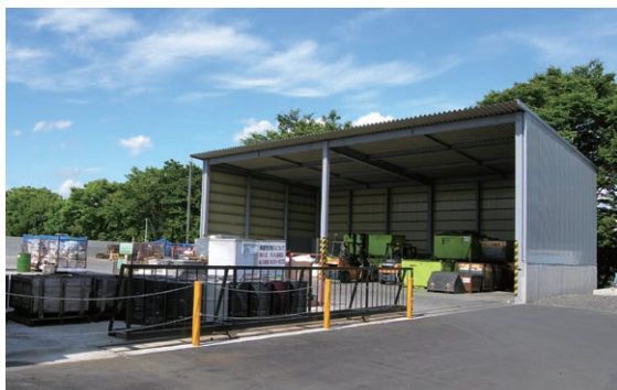
リサイクルセンター（2007年度整備）
