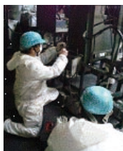
被災会社の設備の復旧作業
