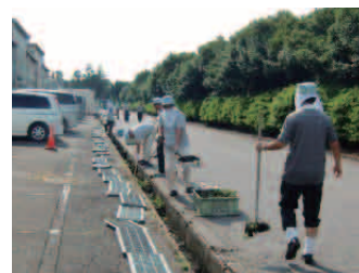
側溝清掃の様子
