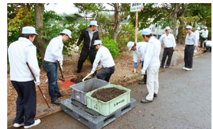
側溝清掃の様子 (2015年10月)
