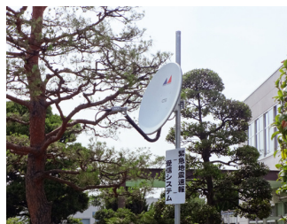
緊急地震速報システム
