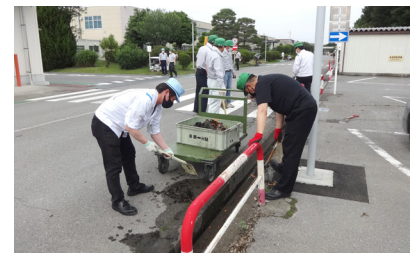
構内側溝清掃の様子
