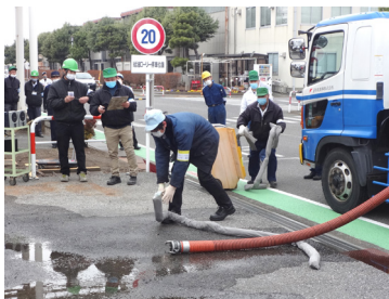
オイルフェンスで油拡散の防止処置
