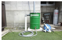
雨水をタンクに蓄え再利用
