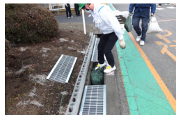
土のうで堰き止め処置
