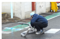
オイルフェンスで油拡散の防止処置
