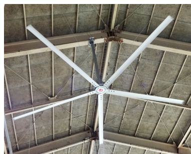
ファン直径：5.2 m 最大風量：18,850 m 3 /min
