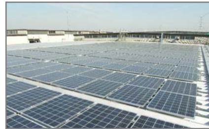
太陽光パネル
