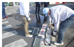
土のうで堰き止め処置
