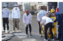
オイルフェンスで油拡散の防止処置
