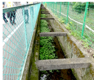
敷地境界北側の様子
