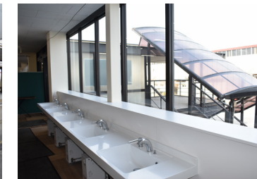
手洗い場を設置(温水機能追加)
