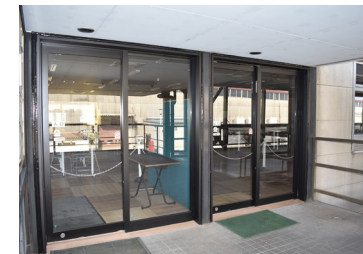
出入口を自動ドア化
