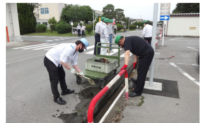
構内側溝清掃の様子
