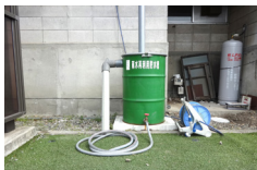
雨水をタンクに蓄え再利用
