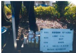
上流側汚染状況調査の様子
