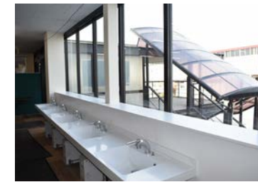
手洗い場を設置(温水機能追加)
