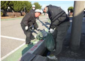
土のうでせき止め処置
