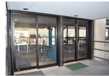
出入口を自動ドア化
